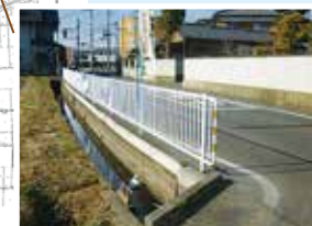
石田地区の水路にフェンス設置
