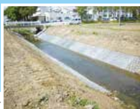
古川の一部護岸工事が完成
