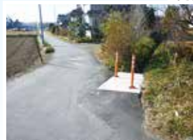
上寺山地区の交差点水路蓋掛けと砂利道の舗装完成
