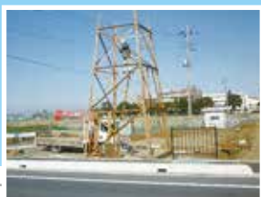
北山田バイパスの第二井戸掘削
