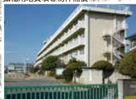
山田中学校エアコン設置、進入道路の拡幅用地買収と物件補償
