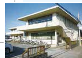
山田市民センターの屋上防水工事完了
