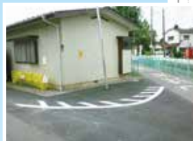
山田西町自治会館の駐車場舗装
