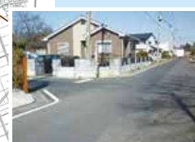
石田地区の一部に公共下水道敷設
