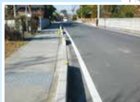
寺山地区の水路蓋掛け歩道完成
