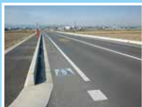
東環状線の一部が完成
