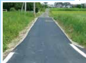
水没道路のかさ上げ工事完成
