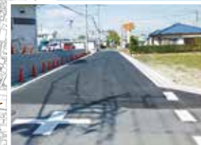
北山田地区の道路拡幅完成
