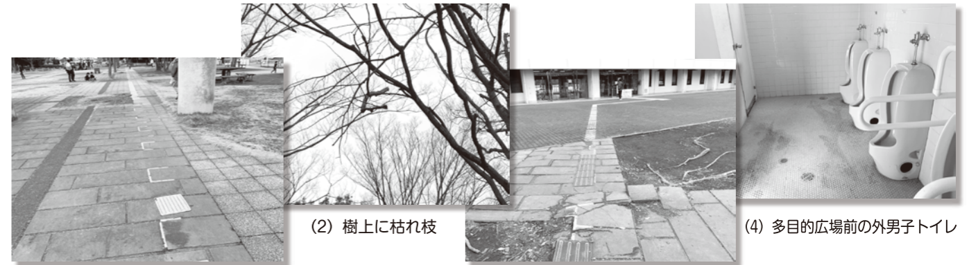
(1) 正面入口広場付近の点字ブロック (2) 樹上に枯れ枝 (3) でこぼこの起伏放置 (4) 多目的広場前の外男子トイレ
