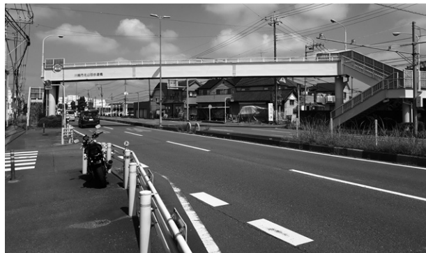
北山田歩道橋
