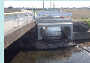
古川の橋拡幅改修
