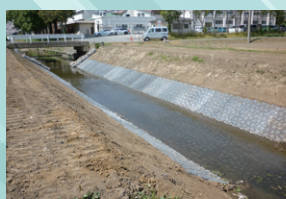
古川護岸改修
