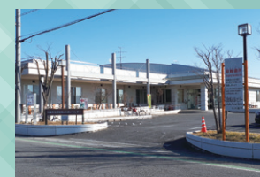
北部ふれあいセンター空調改修
