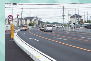
川越北環状線交差点改修
