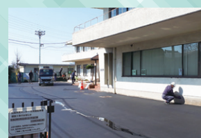
山田市民センター駐車場改修
