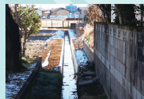
寺山地区水路改修
