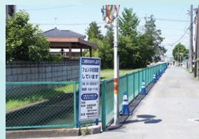
山田西町の古川フェンス改修
