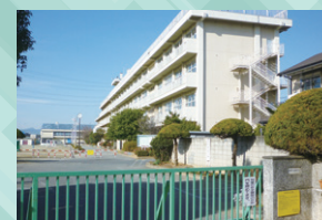
山田小学校エアコン設置とトイレ改修
