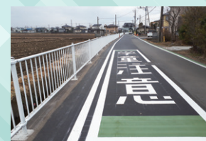
石田地区通学路のフェンス設置
