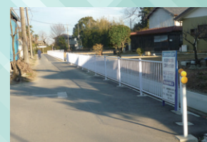
北山田地区水路改修
