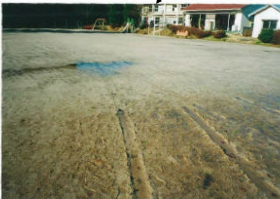
施工 6ヶ月後 改良部舗装と既設グラウンドの凍上と踏圧タイヤ跡の差異状況写真
