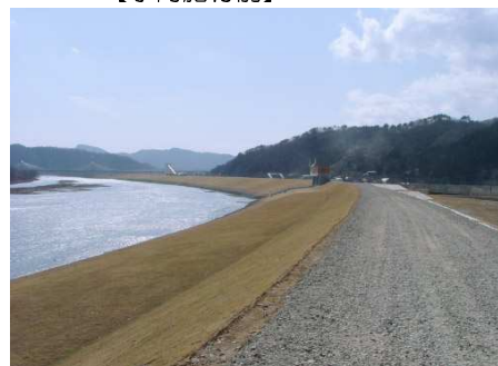
【米代川上流側より】
